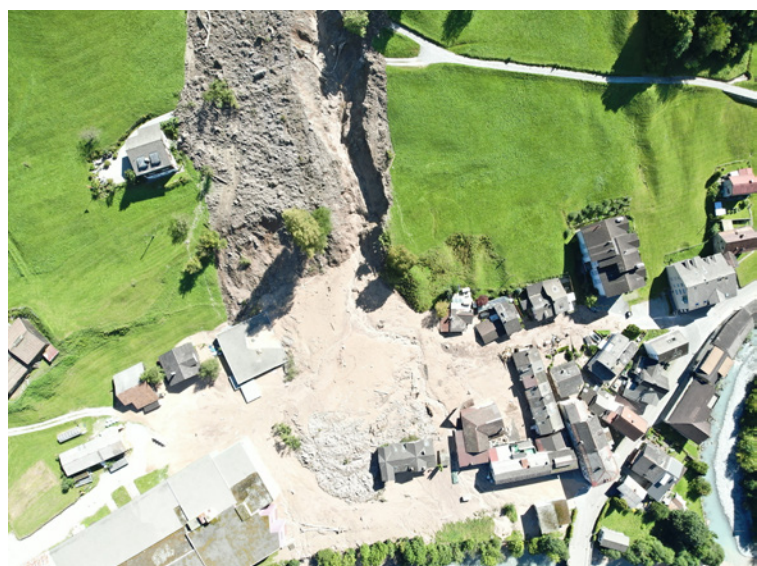
50 Gebäude wurden durch den Erdrutsch beschädigt
