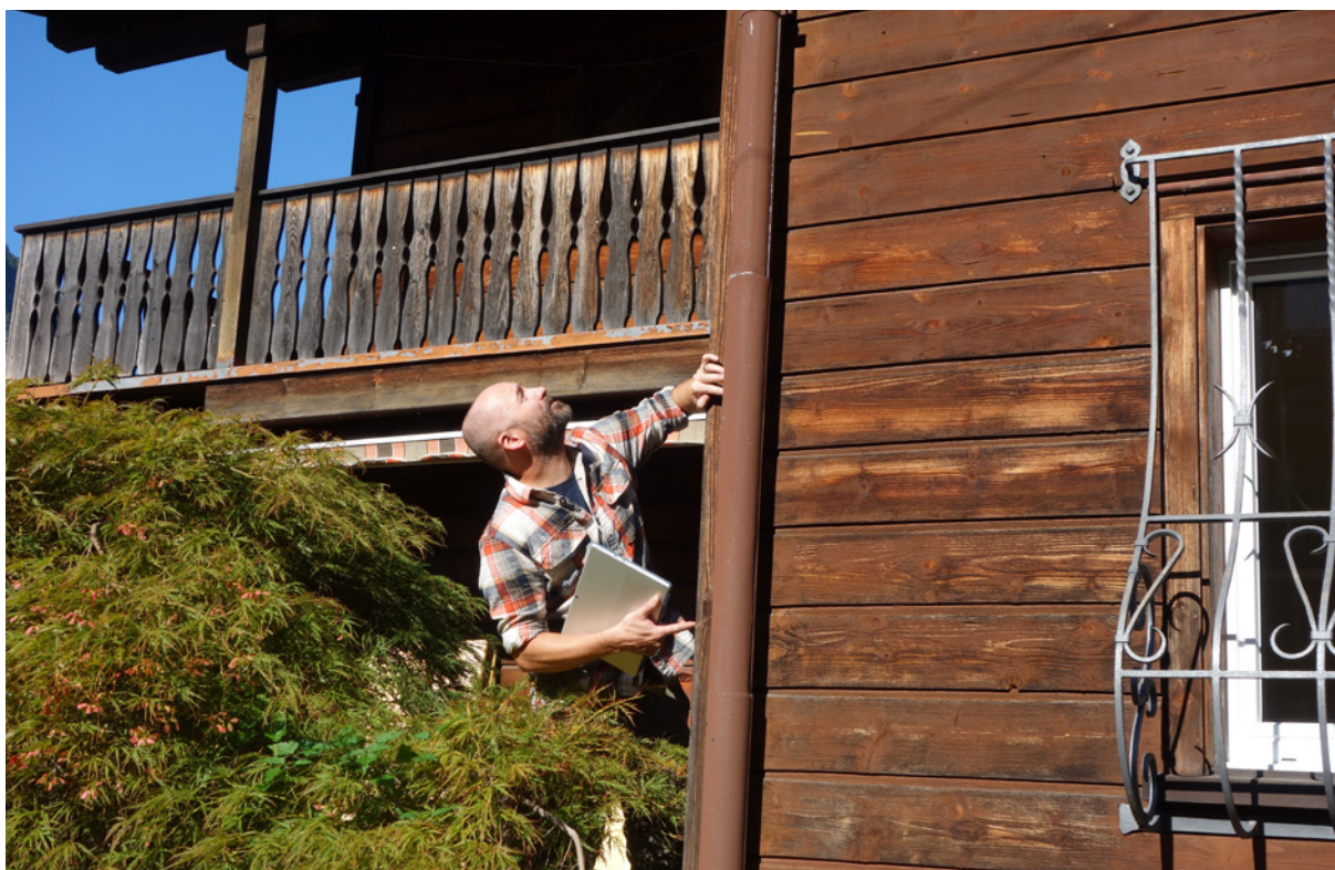
Beim Gebäudecheck EFH werden Risiken im und ums Haus identifiziert
