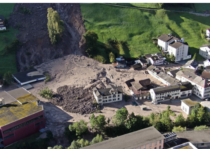
Hangrutsch der Wagenrunse mit grossen Gebäudeschäden
